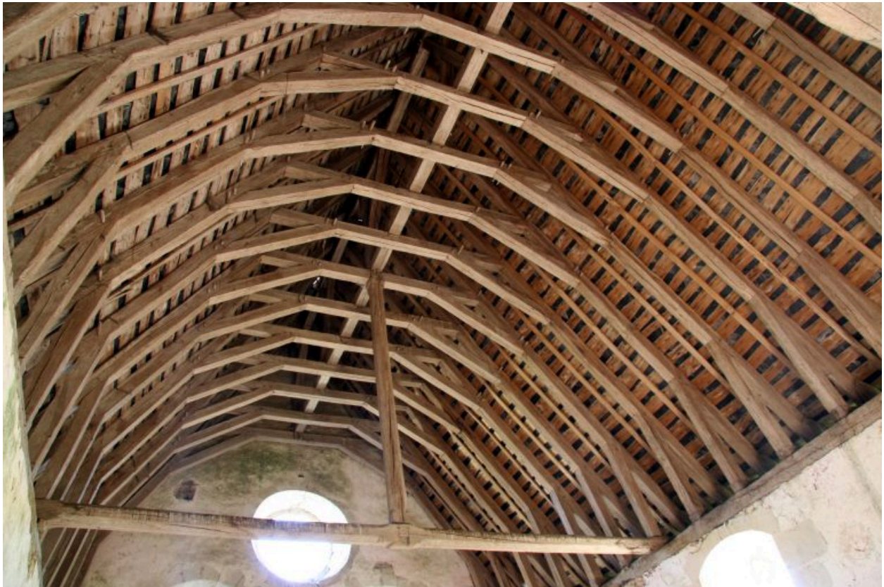
La charpente à chevrons portant ferme.
