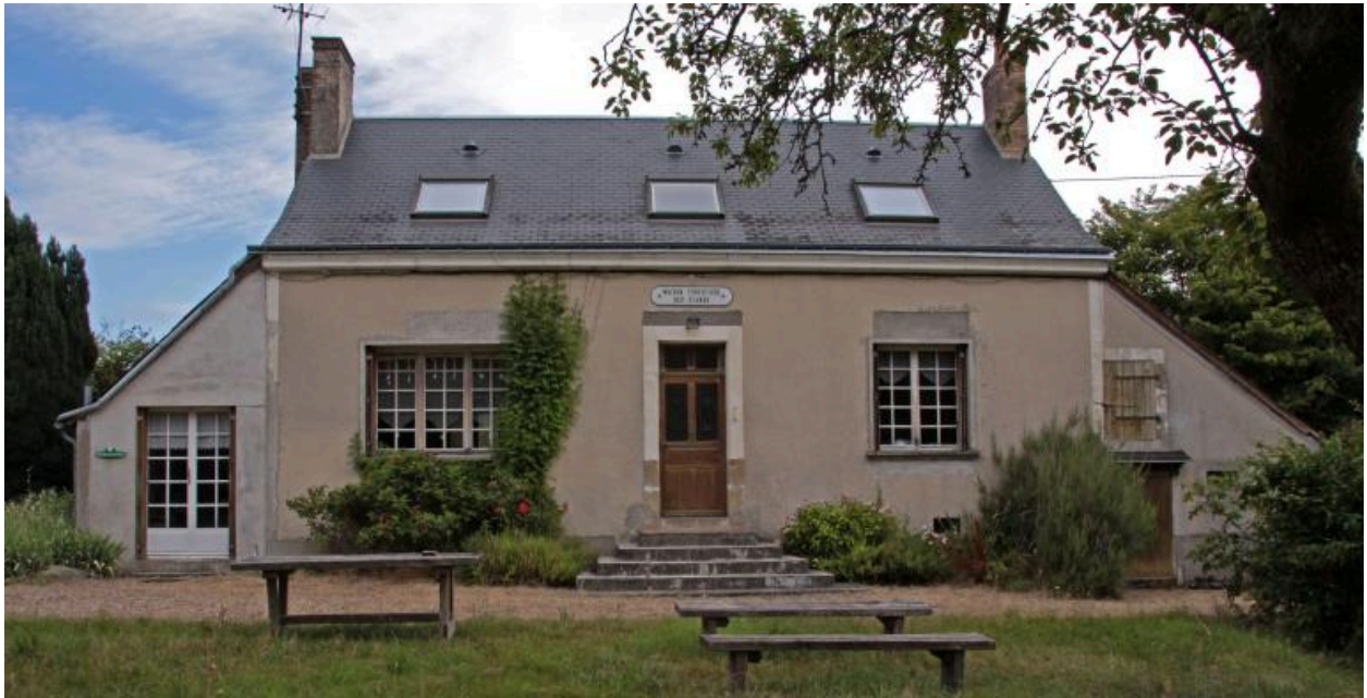
Maison forestière : façade antérieure.
