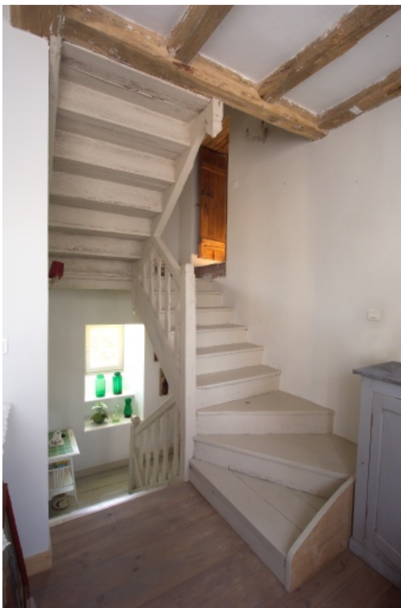
Vue de l'escalier depuis le premier étage.
