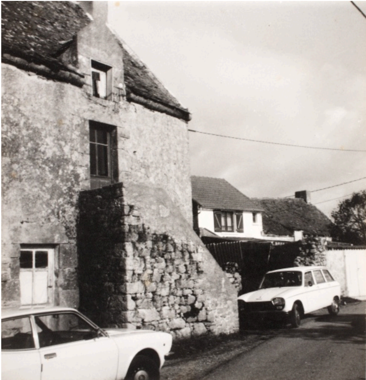
Vue de la façade principale du 1er logis (9 rue des Rigadeaux) en 1976.
