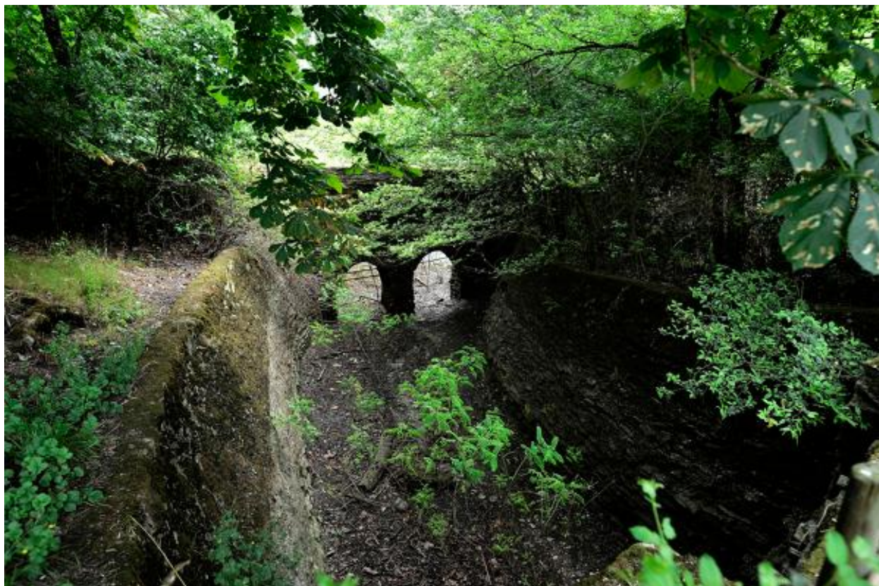
Les Vaults. Vue des jardins et du pont enjambant une allée.
