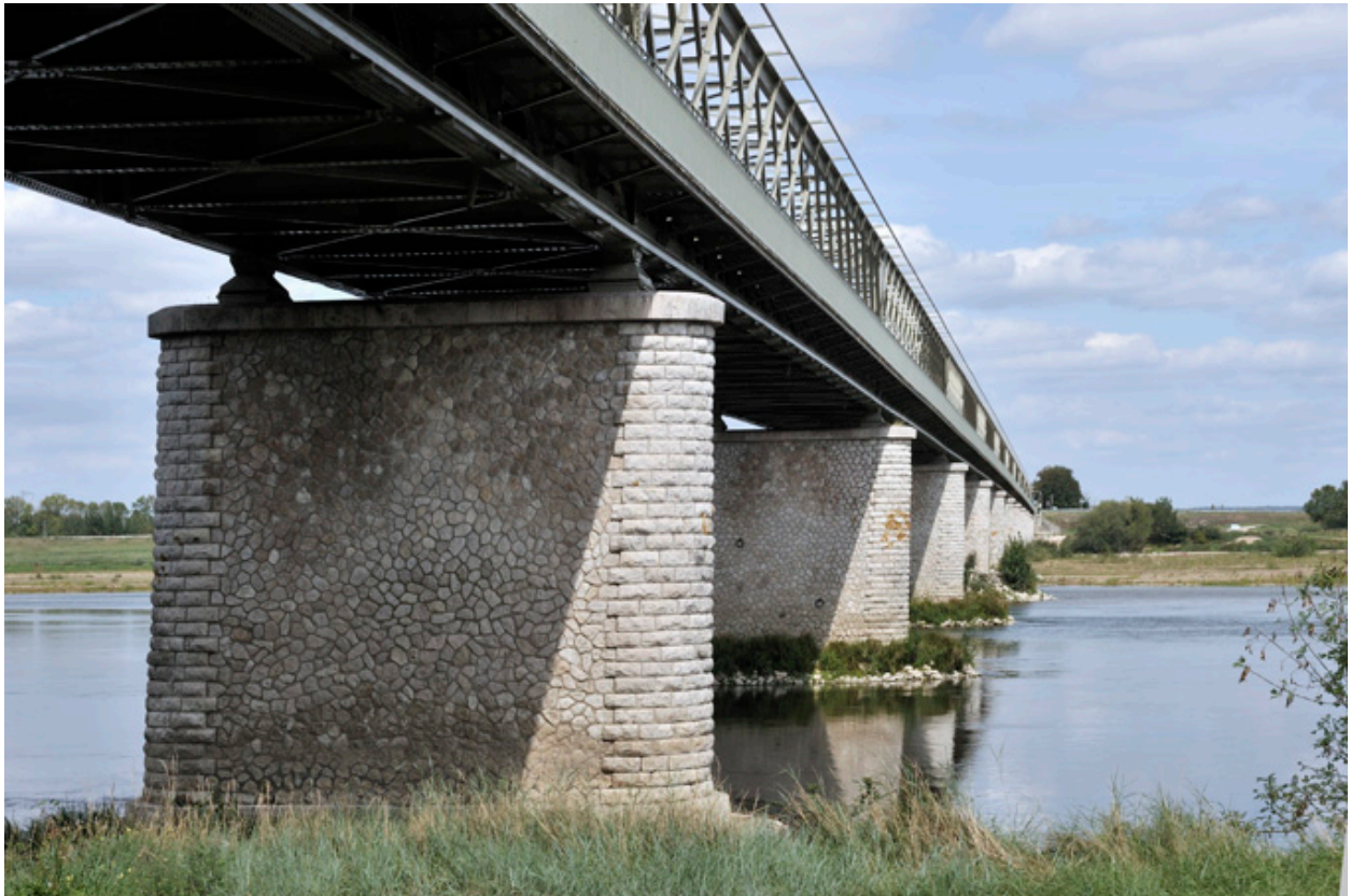
Piles et longerons du pont
