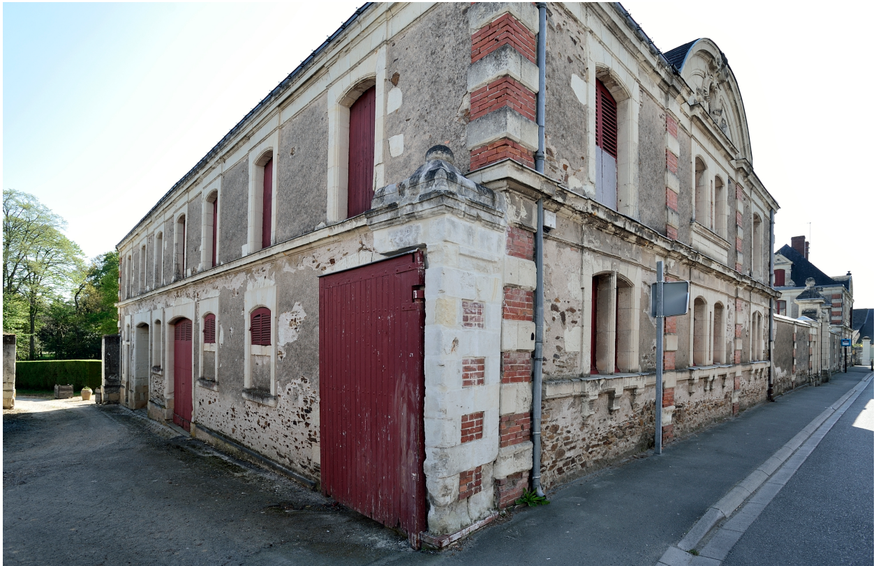
Ecuries. Vue depuis le nord-est.
