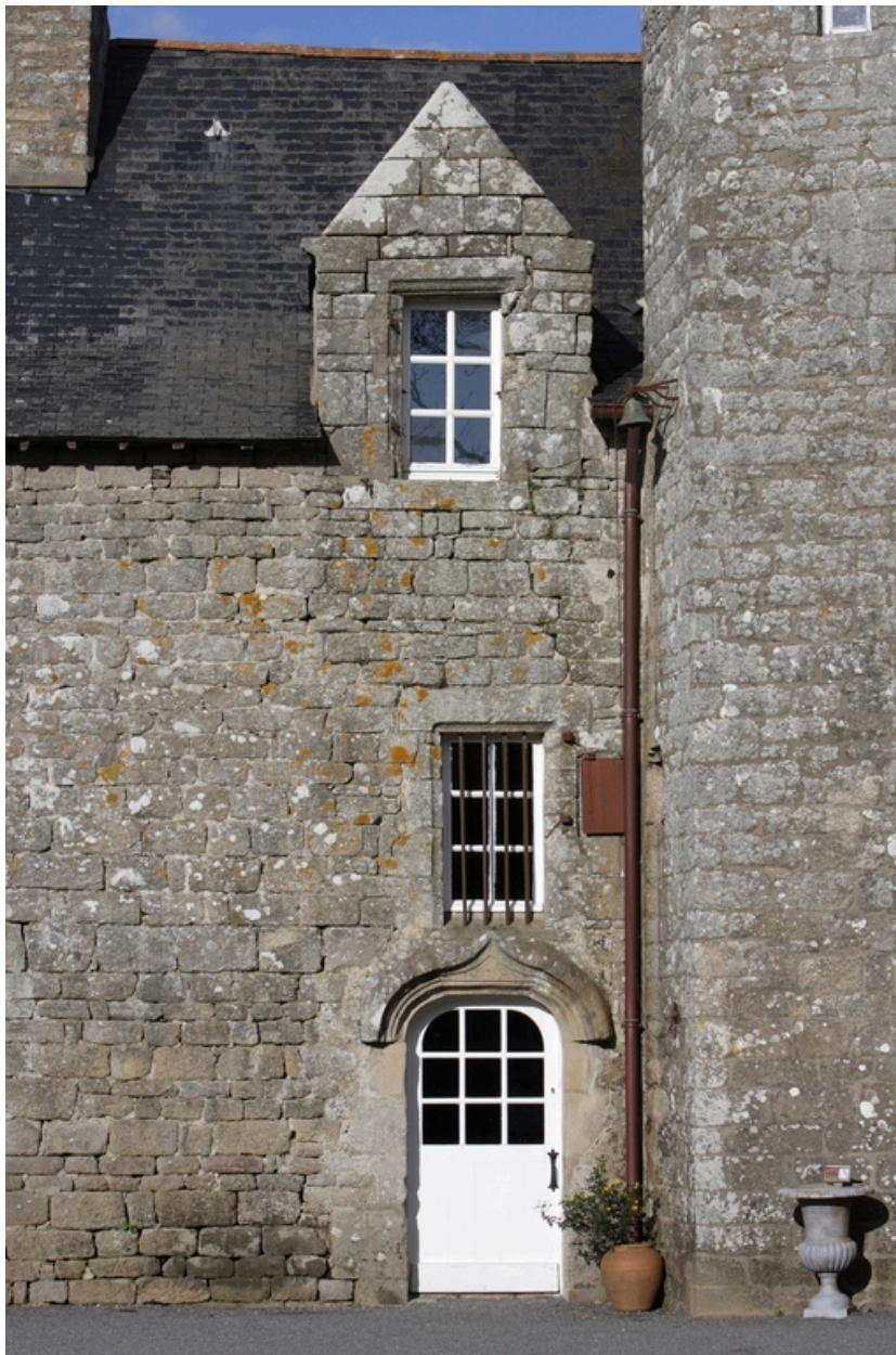
Logis. Aile nord. Façade sud. Détail de la travée de baies.
