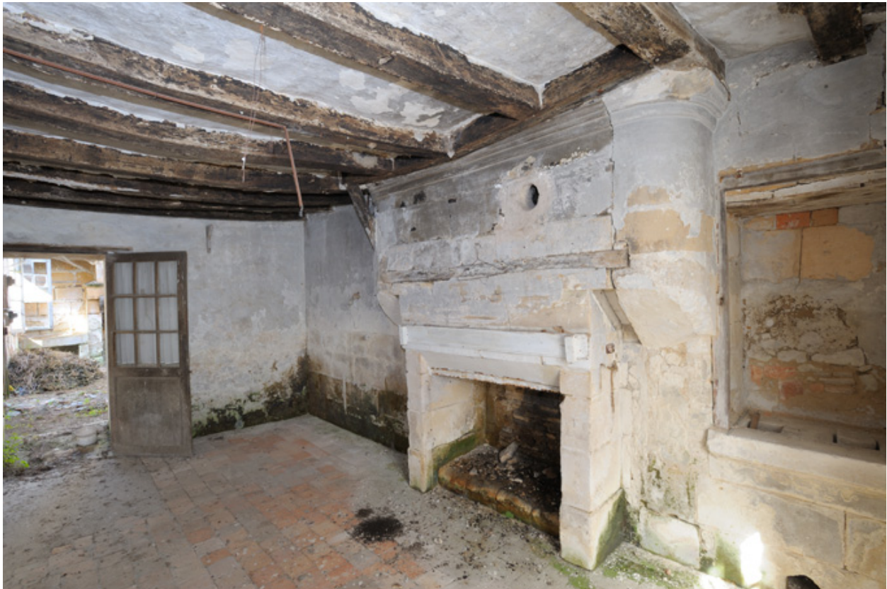
Rez-de-chaussée, salle nord. Cheminée de la première moitié du XVIe siècle (remaniée au XIXe siècle). A droite, un potager.
