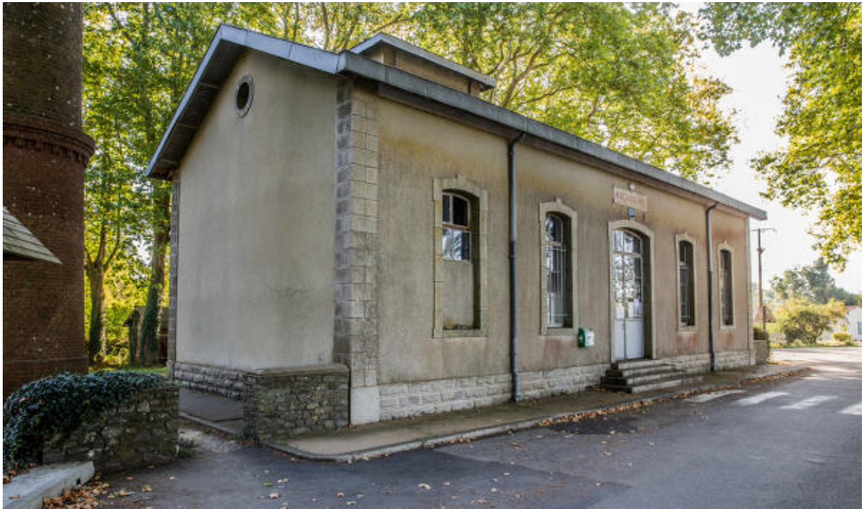
Façade antérieure et pignon nord.
