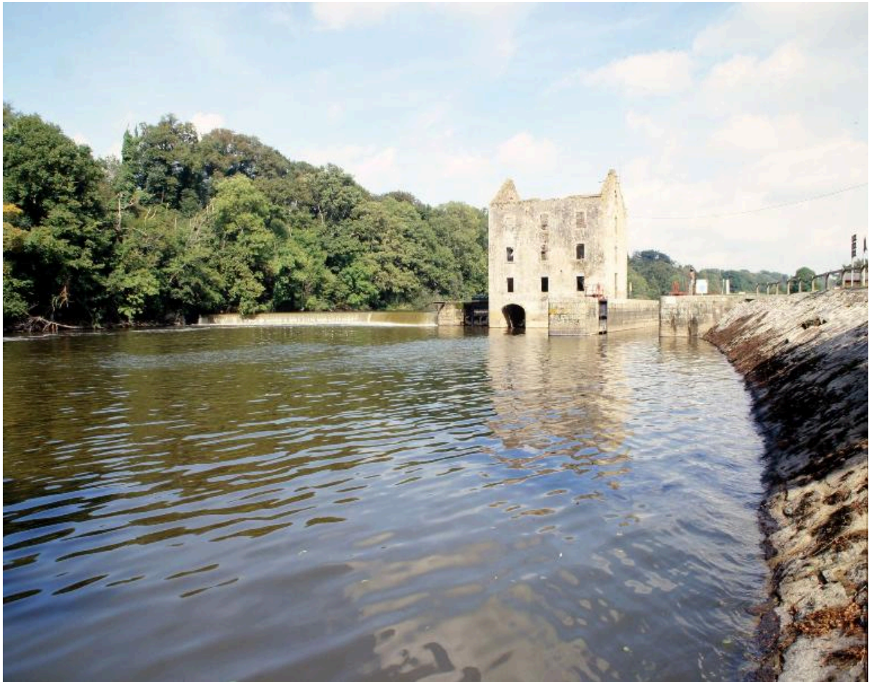
Vue d'ensemble du site d'écluse : barrage, vestiges de la centrale hydroélectrique, moulin, écluse.
