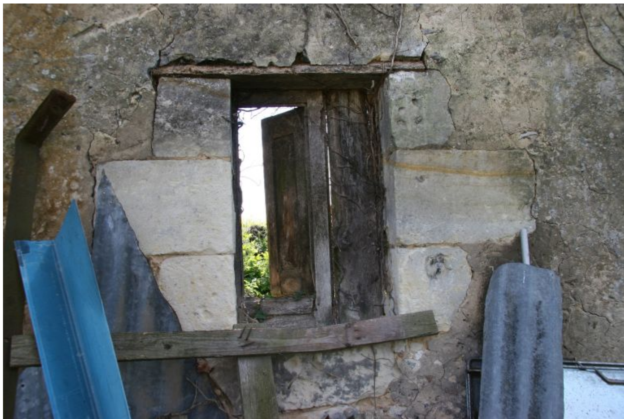
Maison 2, façade antérieure : fenêtre avec un volet à petit panneau (réemploi ?)
