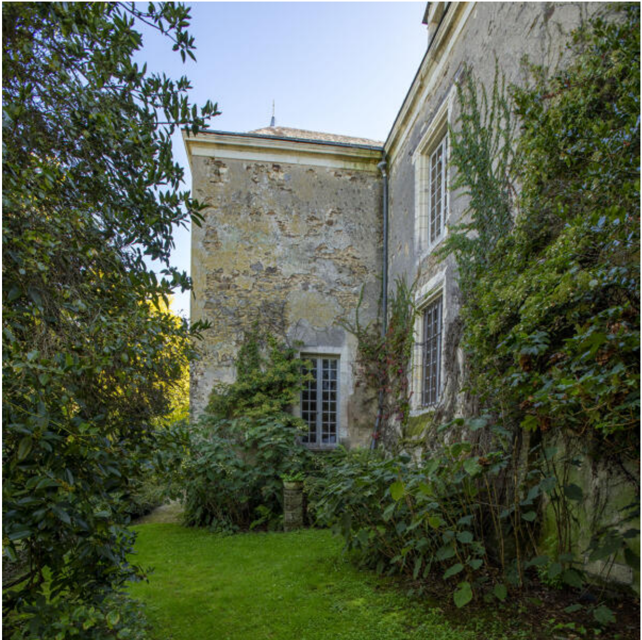
L'avant-corps de l'élévation postérieure.
