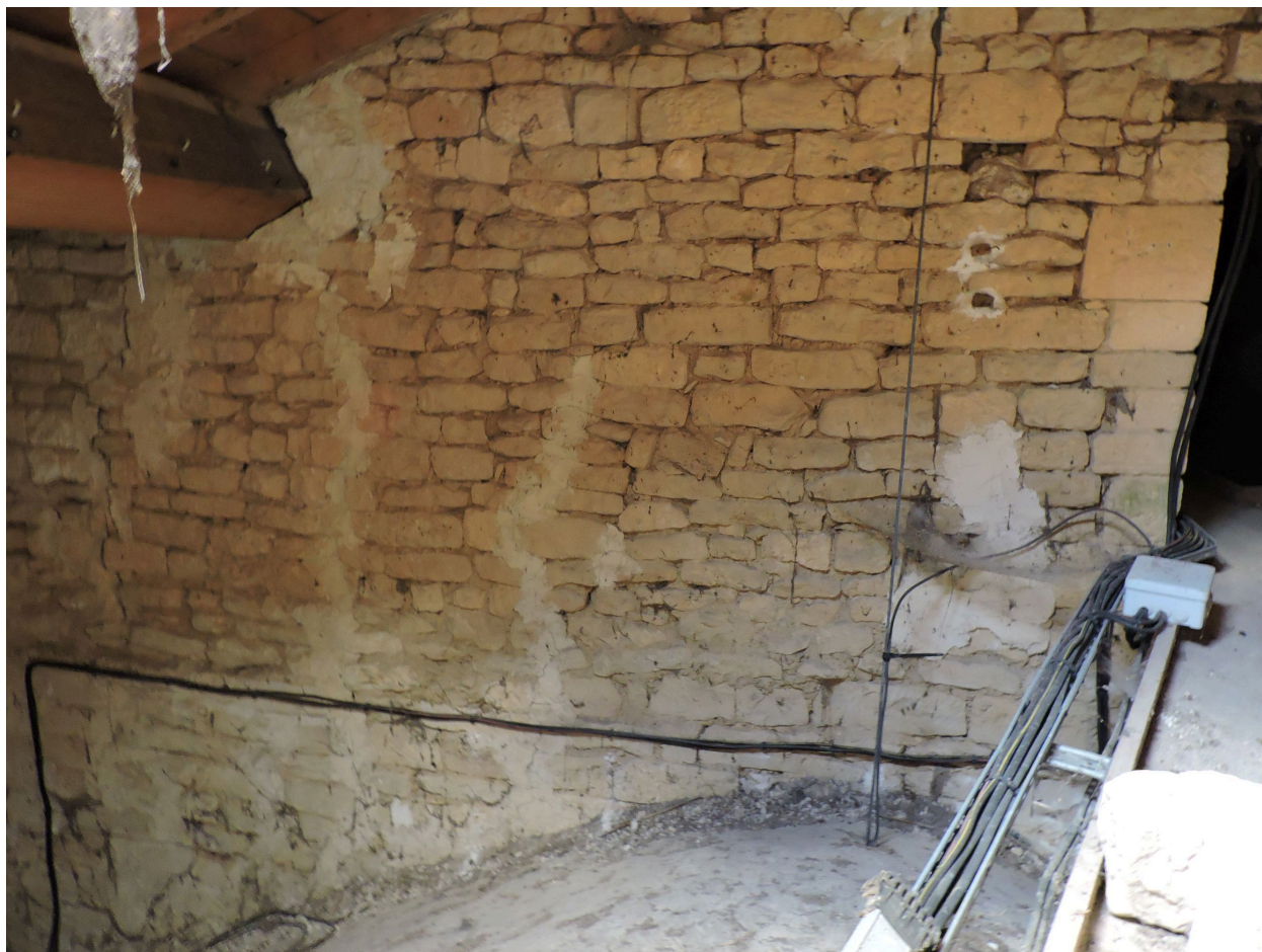
Le mur de refend entre les deux travées du choeur, côté est.
