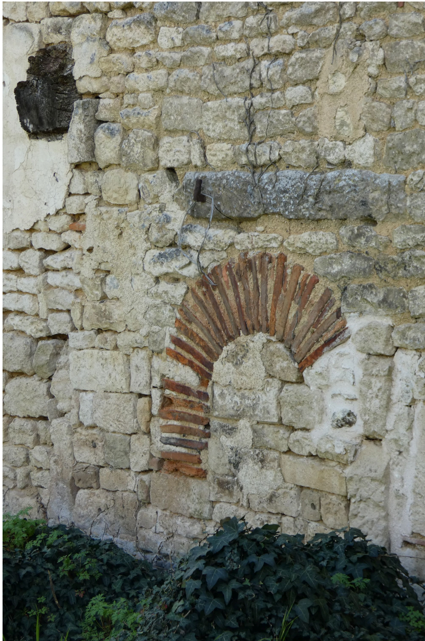
Vestiges de four sur le côté nord de l'ancienne ferme.
