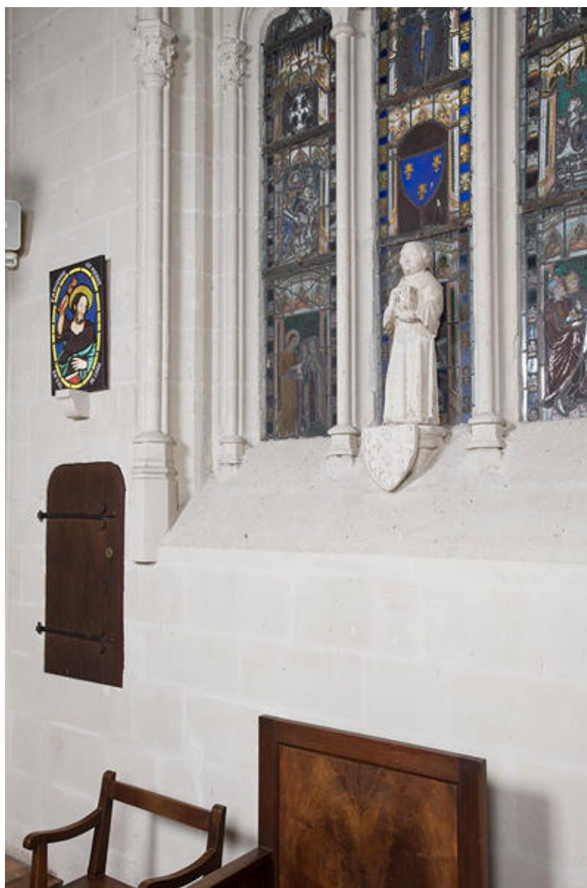
Choeur. Détail de la grande verrière et de la console sculptée des armes d'Anjou et de Bretagne.
