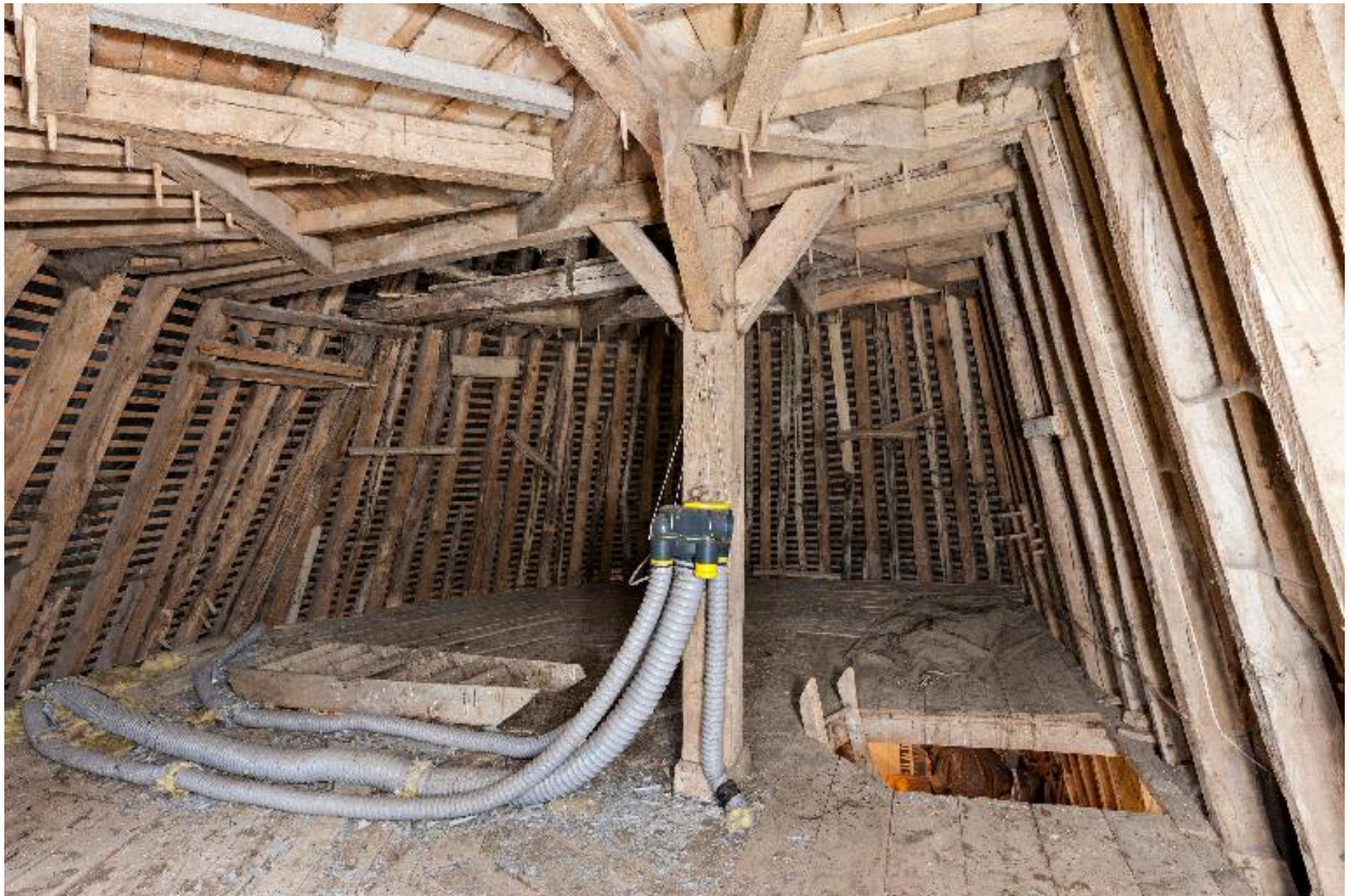
Vue partielle de la charpente de la tour sud : le deuxième niveau vu depuis l'est.
