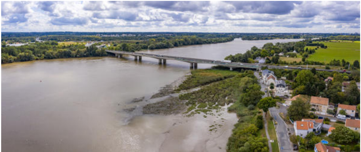
Vue du pont de Bellevue.
