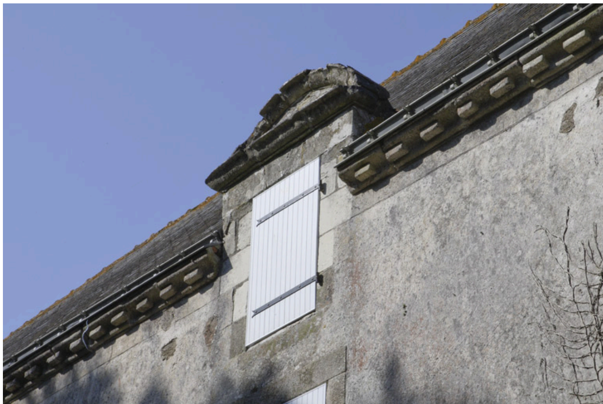
Logis. Façade ouest. Lucarne.
