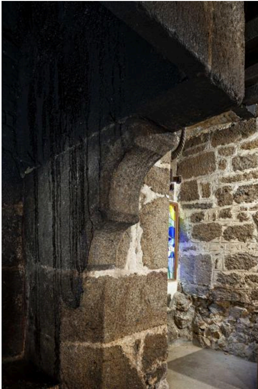
Corbeau droit de la cheminée.
