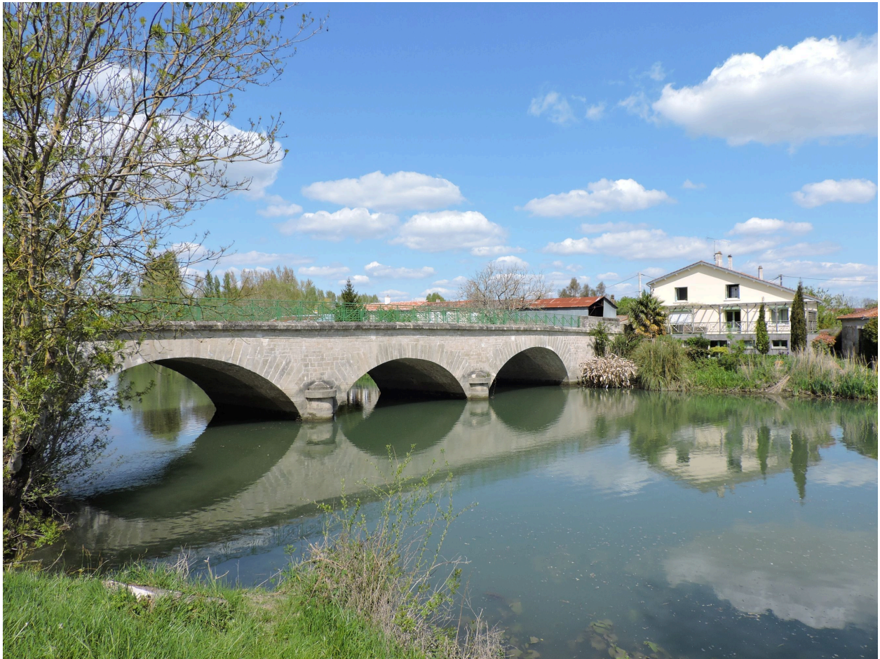
Le grand pont vu côté amont, depuis le sud.
