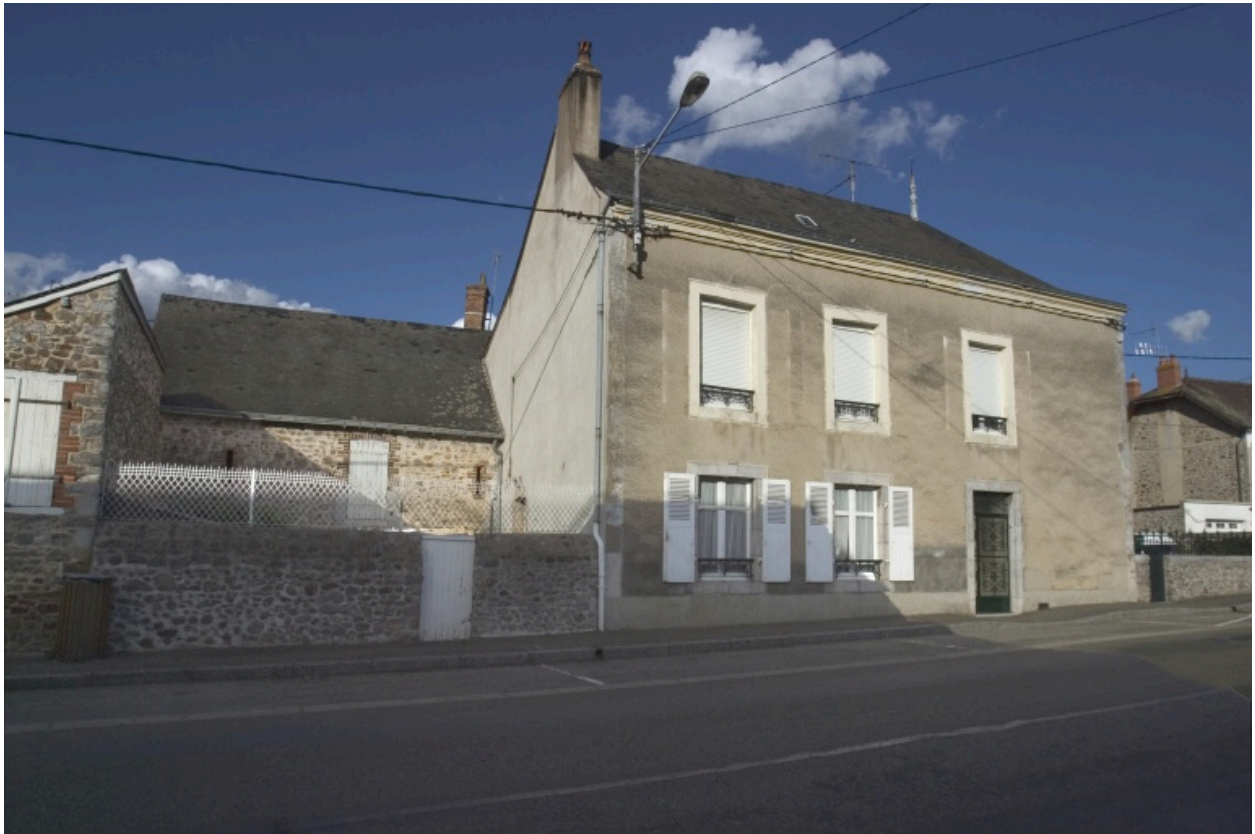
Vue de la maison et de l'atelier depuis la rue Robert-Glétron.
