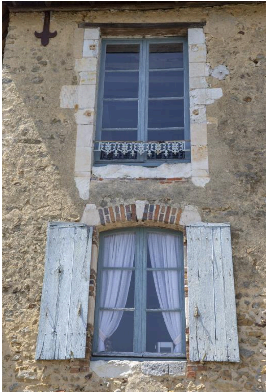
Les fenêtres du pavillon côté rue.
