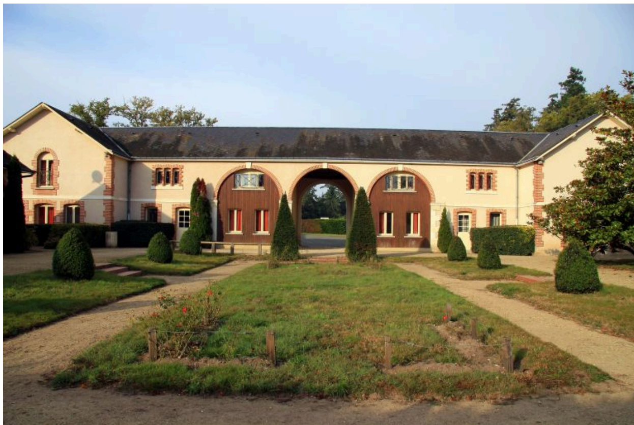
Les communs, entrée ouest : façade sur cour.
