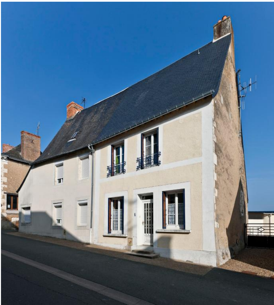
Façade sur rue, prise depuis le sud-est.
