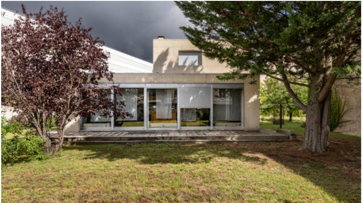
Vue des façades sud de la maison du proviseur depuis le jardin.
