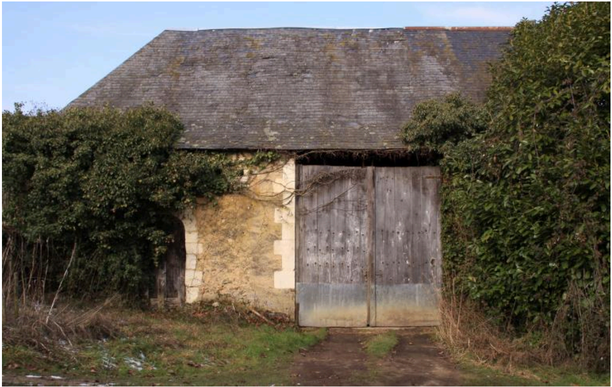
Grange : façade antérieure sur cour.
