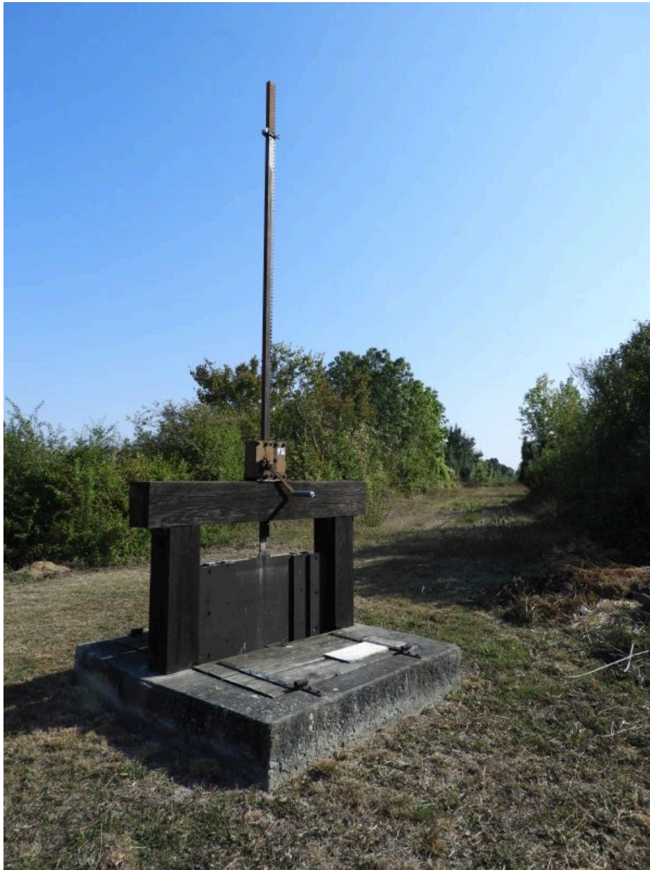
La vanne à l'embouchure du petit canal, vue depuis l'ouest.
