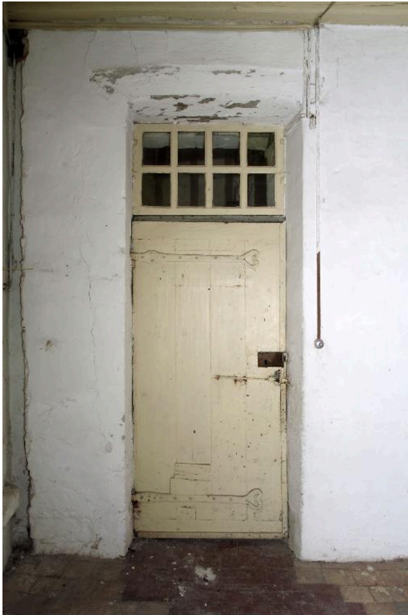
Le corps secondaire, premier étage, vue de la porte palière depuis la première pièce.
