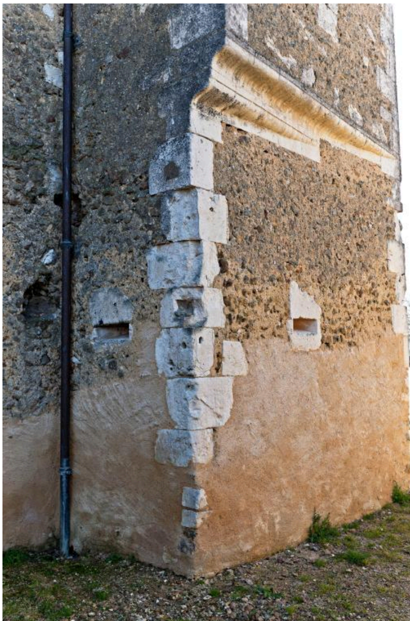
Pavillon d'angle sud-ouest bastionné : détail du bastion côté basse-cour.
