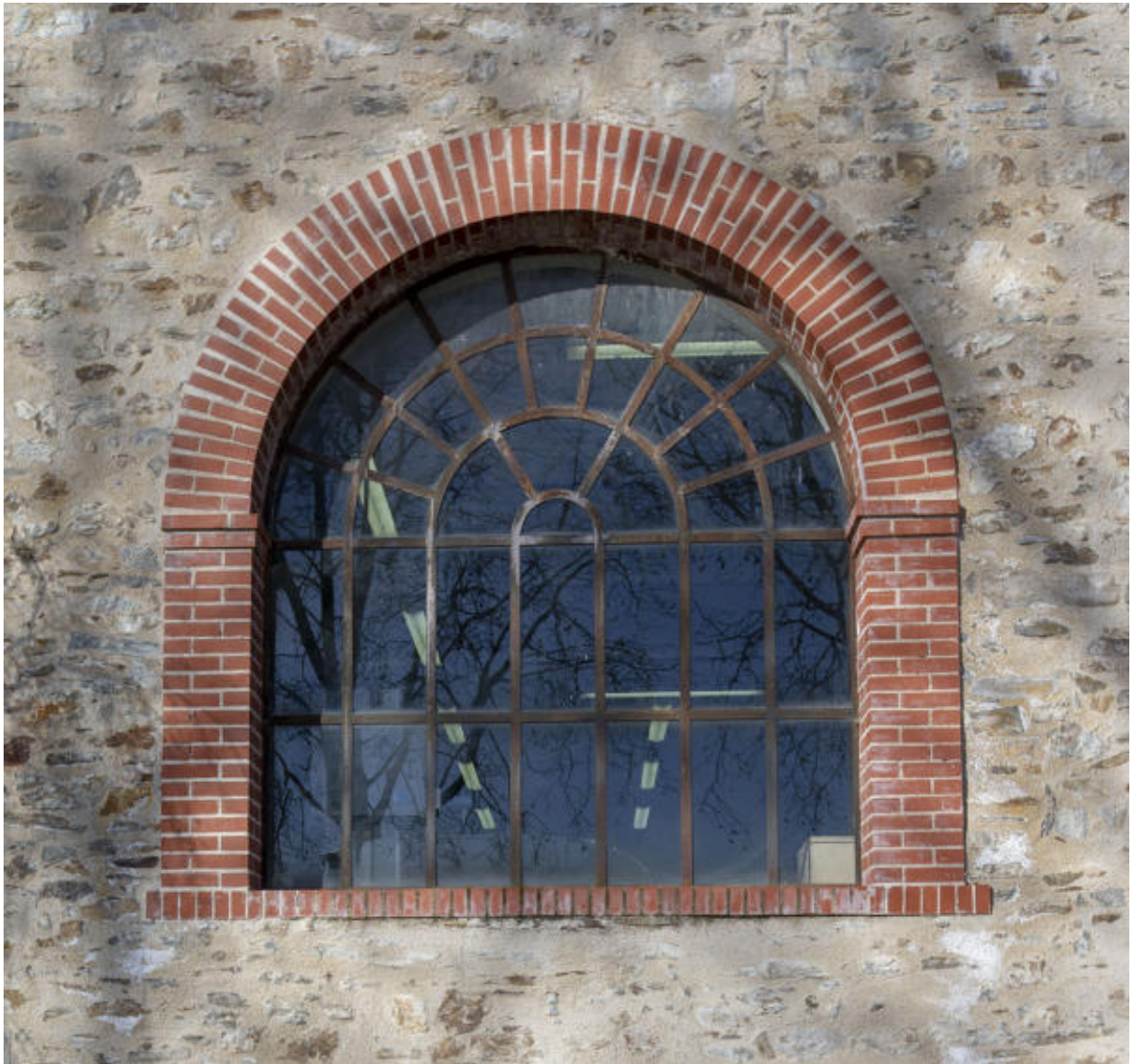
Détail d'une baie de l'atelier de la fonderie de cuivre.
