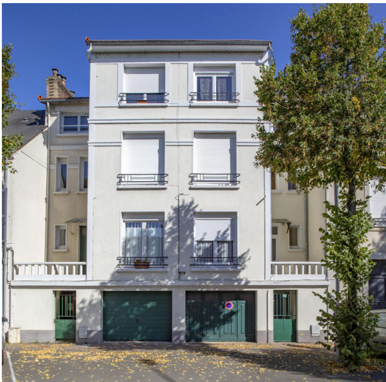
Vue d'un immeuble boulevard Anatole France.
