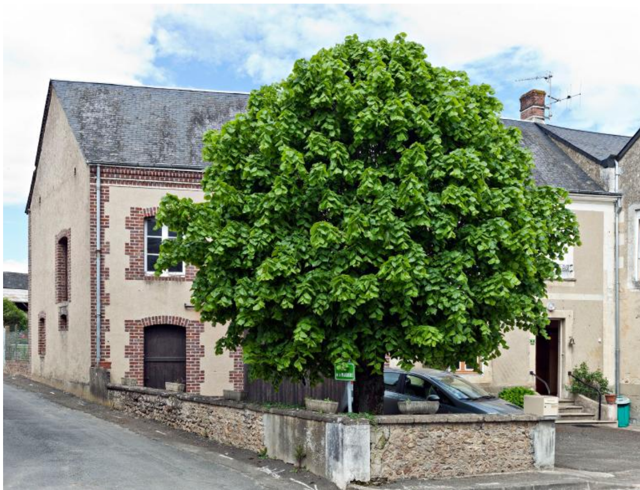
7, rue du Dinan : maison, façade sur cour.
