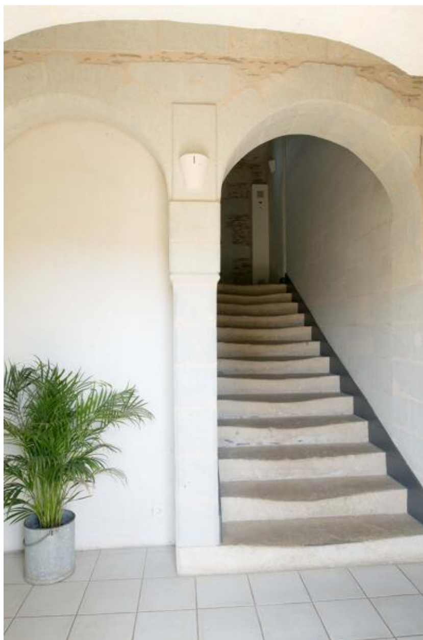
Vue de l'escalier depuis le palier du rez-de-chaussée.
