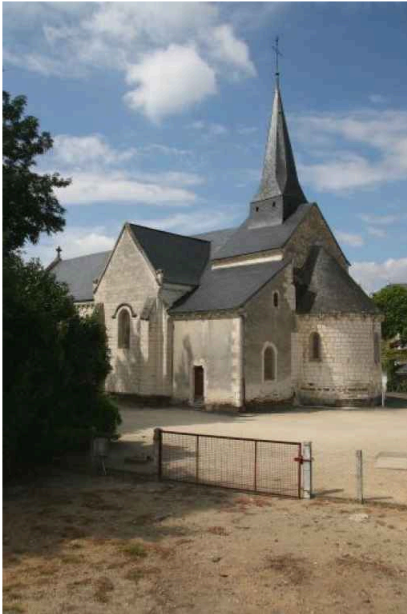
Vue de volume du chœur prise du sud-est.
