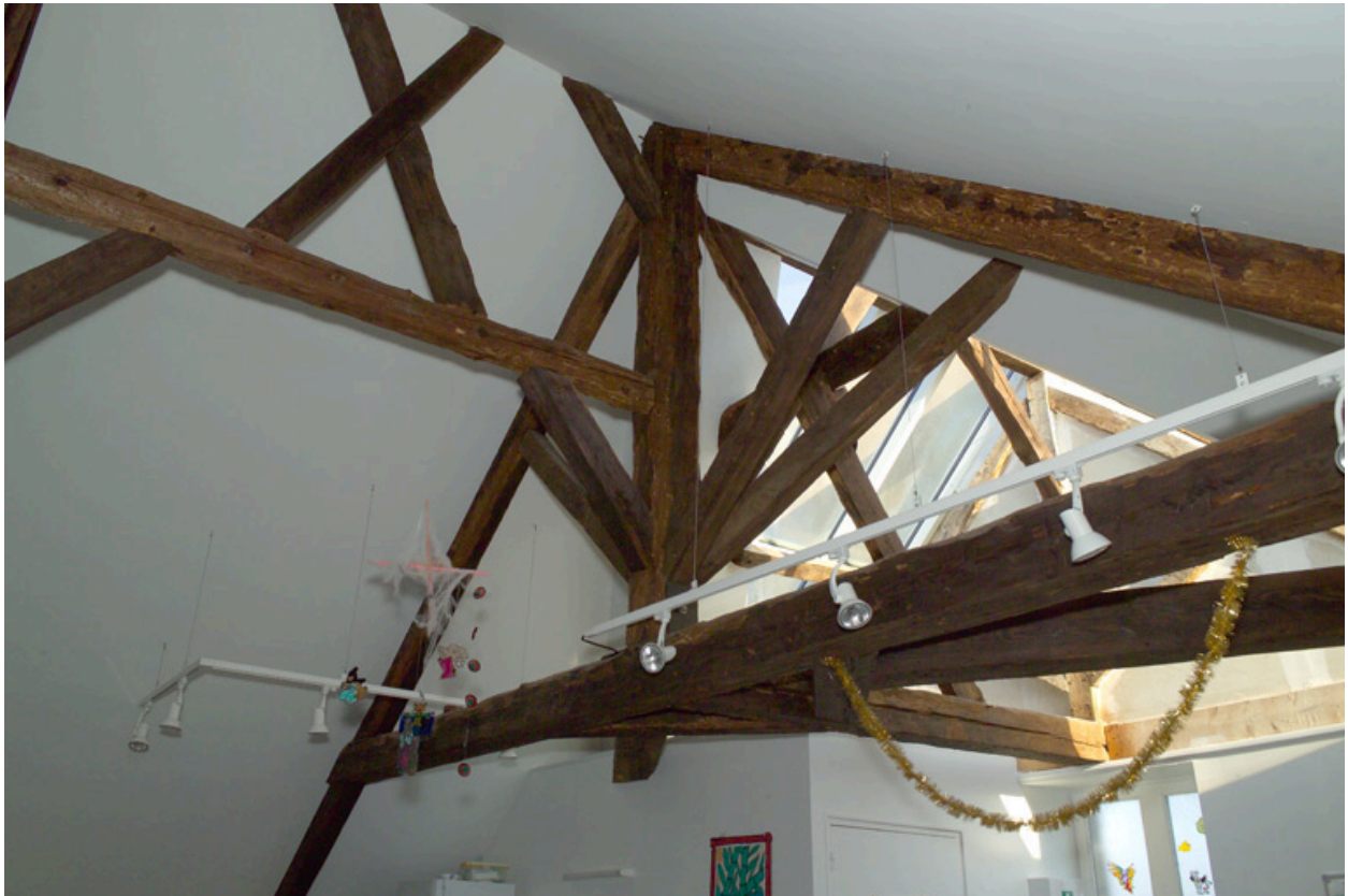
Comble, détail de la charpente.
