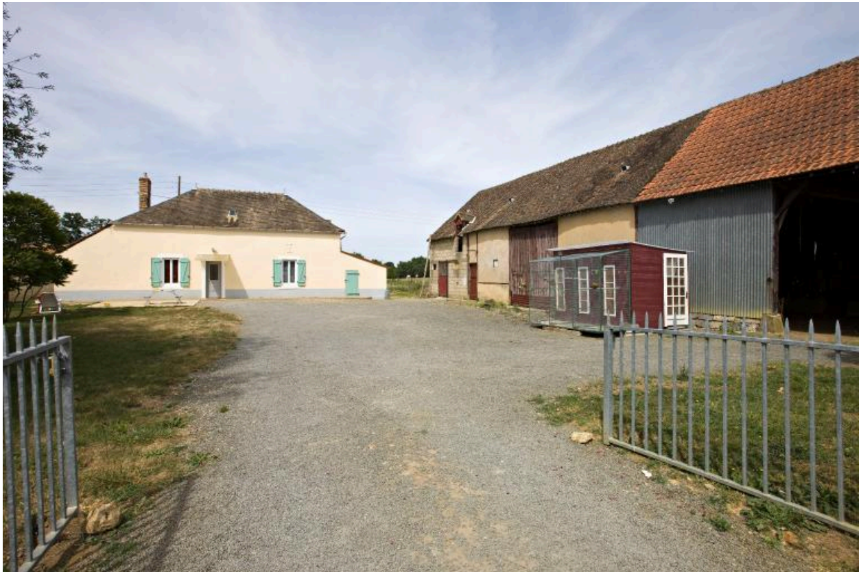
La Sasserie, ferme construite ex-nihilo vers 1901
