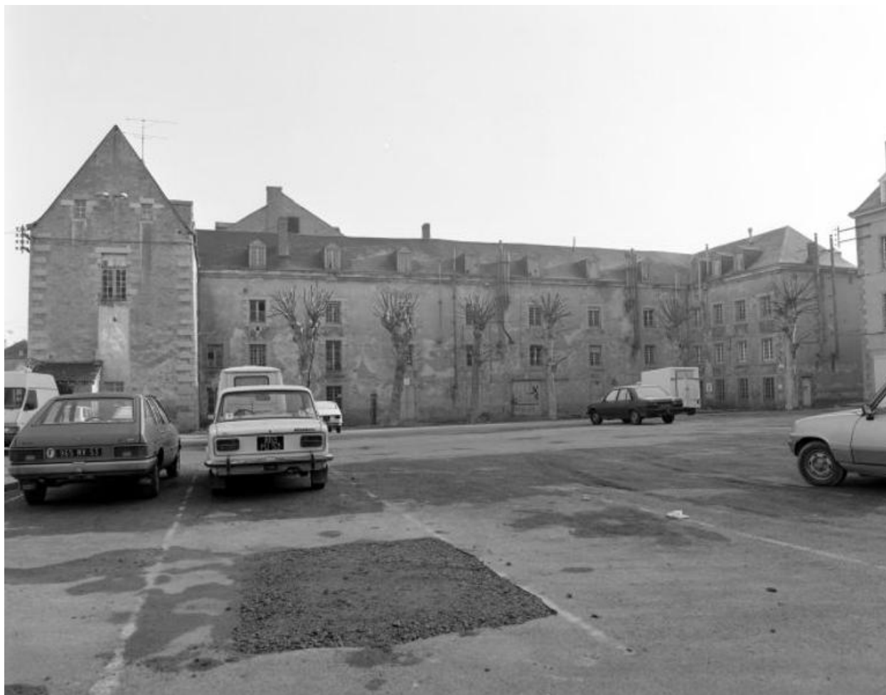
Couvent, corps de logis nord-est, élévation intérieure : vue d'ensemble.
