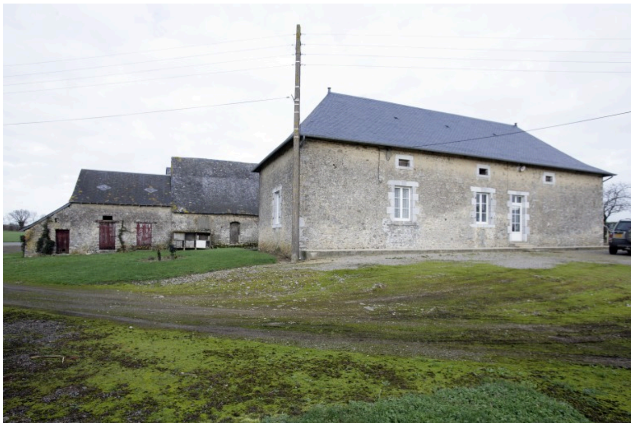
Le second logis-étable et le logis de ferme vus depuis la cour au sud-est.
