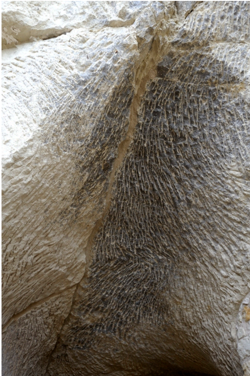
Abri troglodytique secondaire, en contrebas du site. Traces de pics de purge du ciel rocheux (2).
