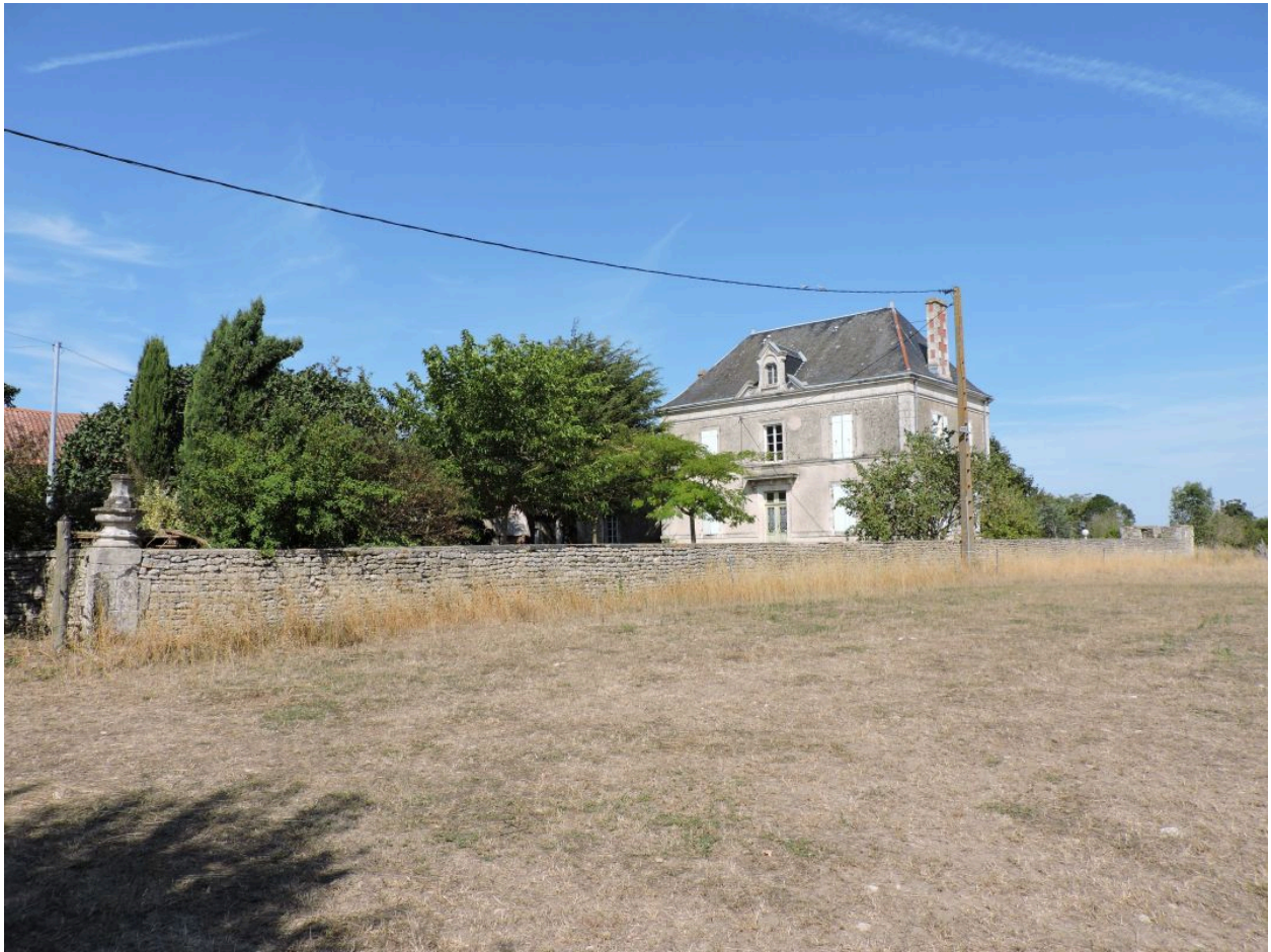
La propriété et son clos de mur vue depuis le sud-ouest.
