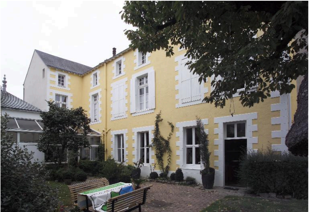
Vue d'ensemble des façades postérieures depuis le jardin.
