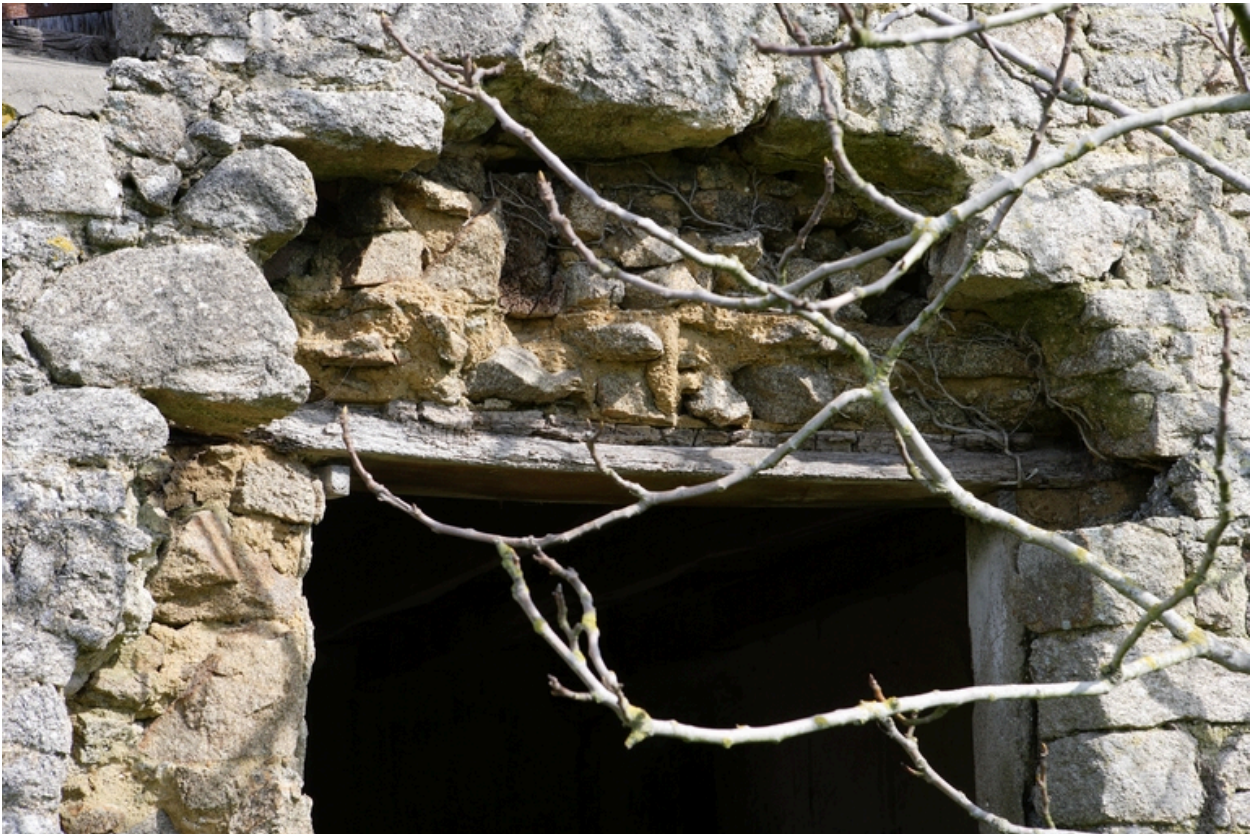
Détail du blocage de moellons entre les deux parements.
