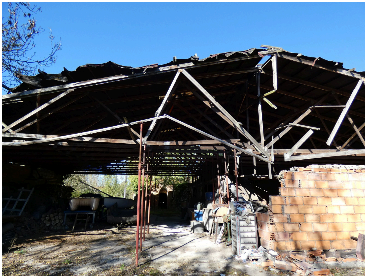
Le séchoir vu depuis le sud.
