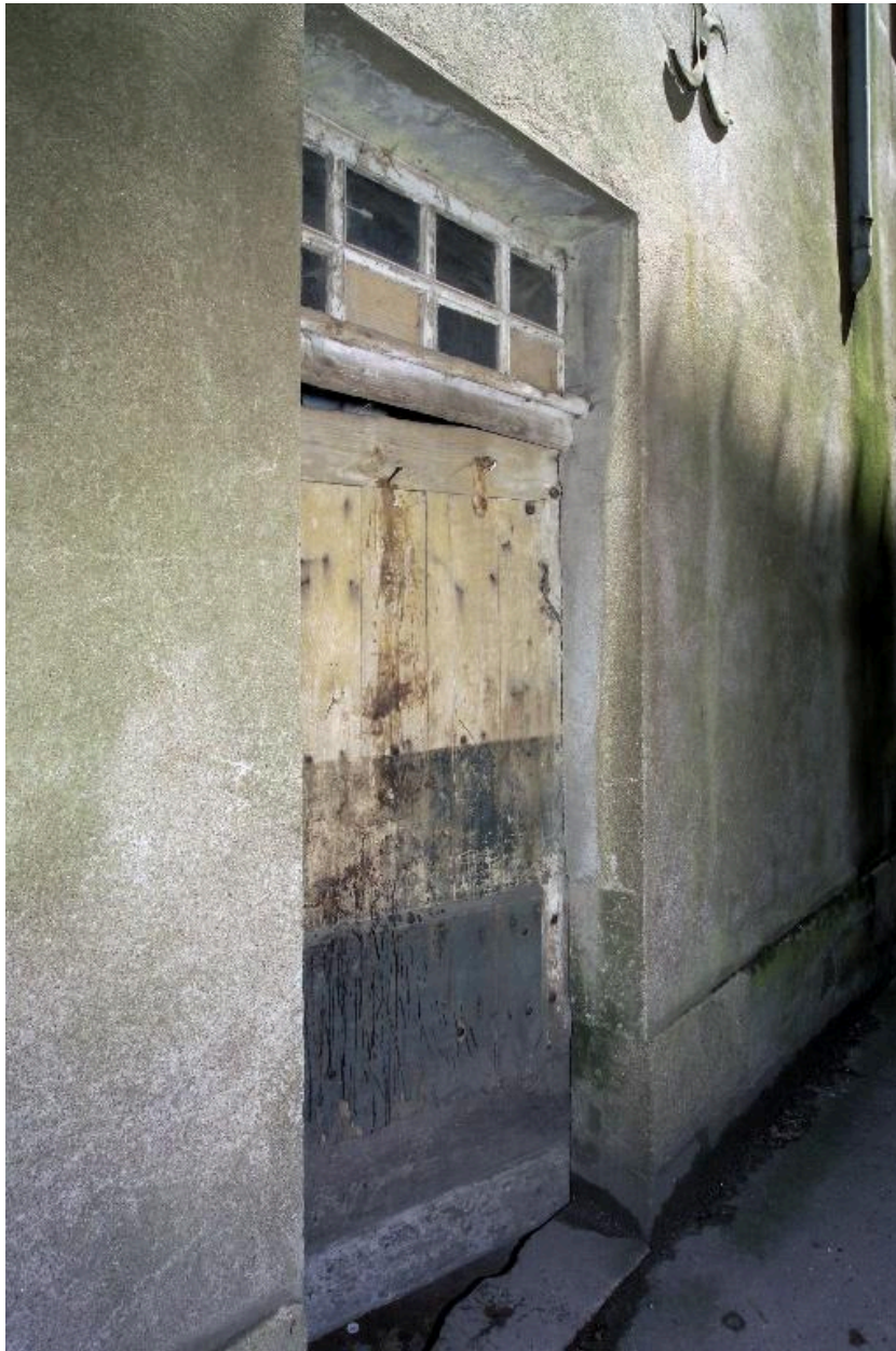
Le corps secondaire, détail d'une des portes sur l'allée permettant l'accès à la buanderie.
