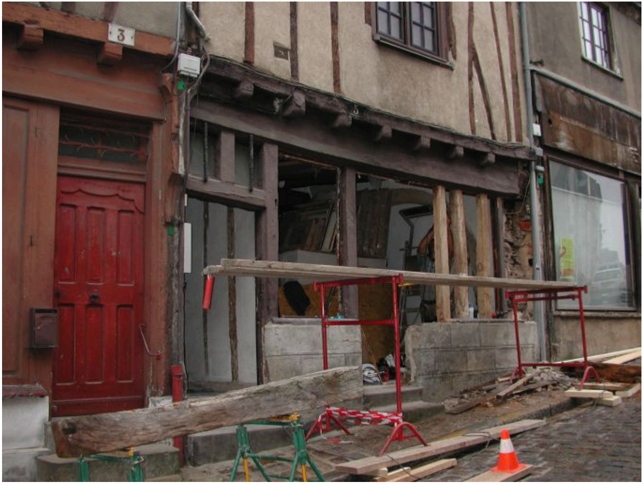
Boutique en cours de remaniement : vue d'ensemble pendant travaux sept.- oct. 2002.
