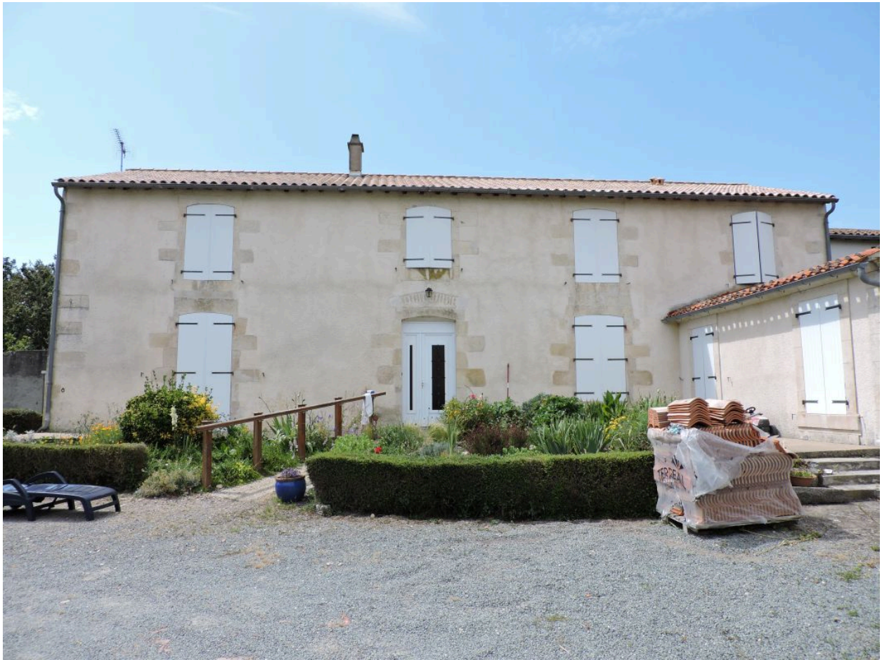
Le logis vu depuis le sud-est.
