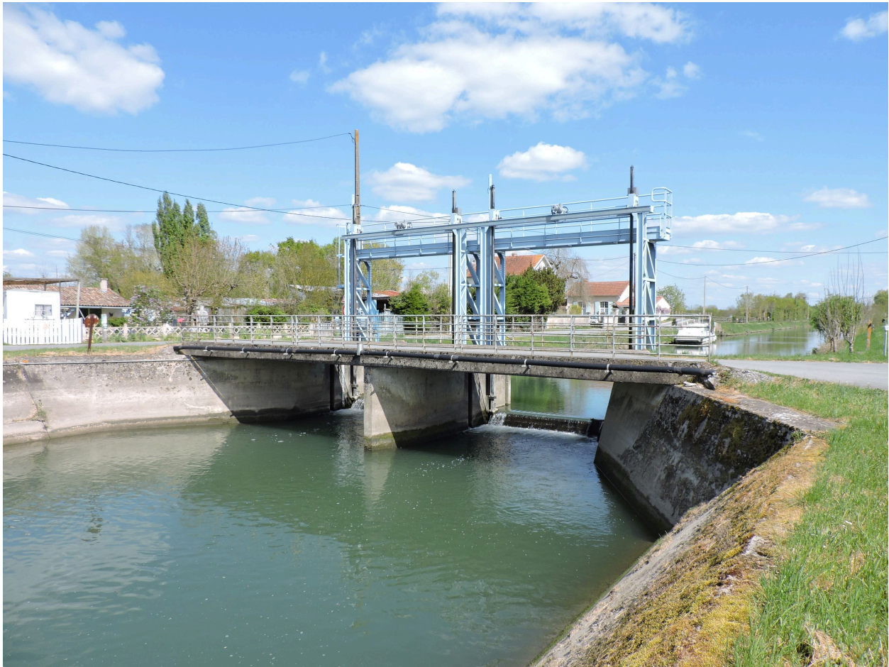
Le barrage vu depuis l'aval, au nord-ouest.
