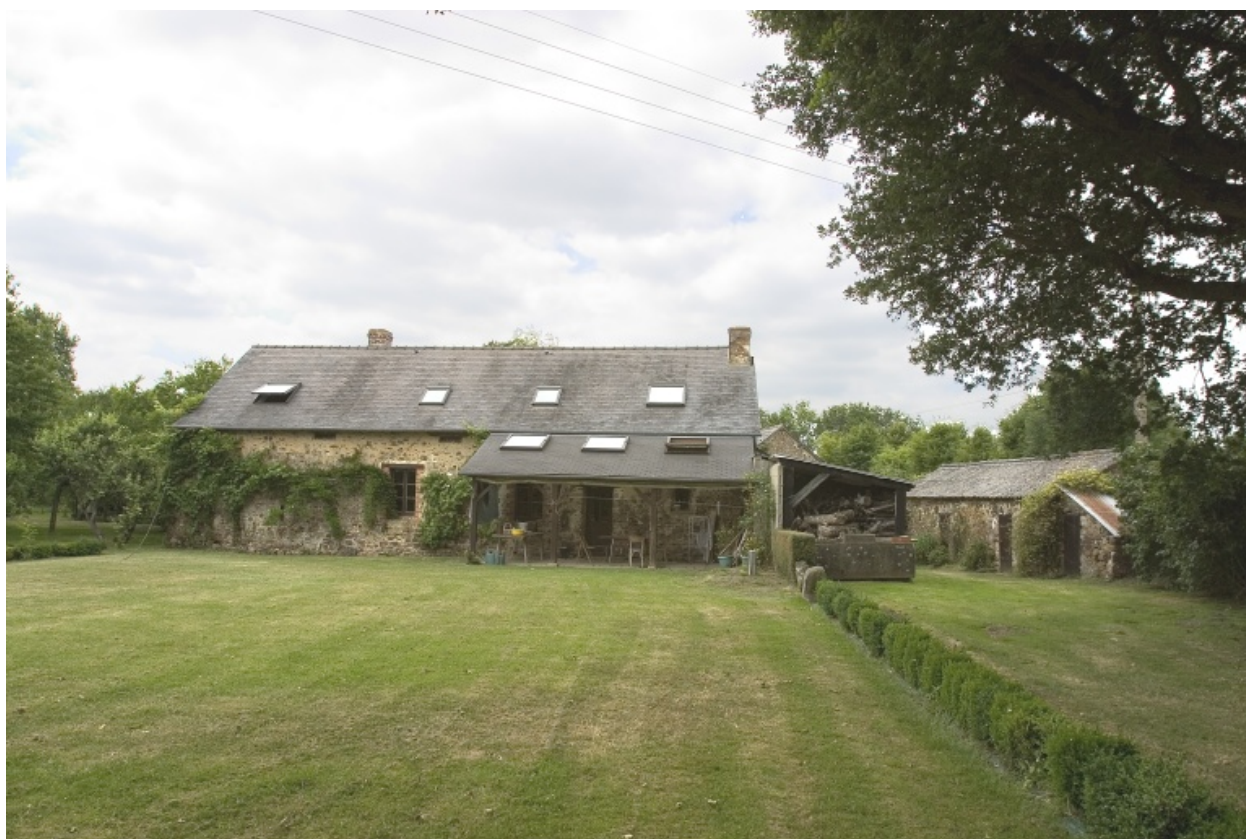
La façade postérieure du logis et la porcherie.
