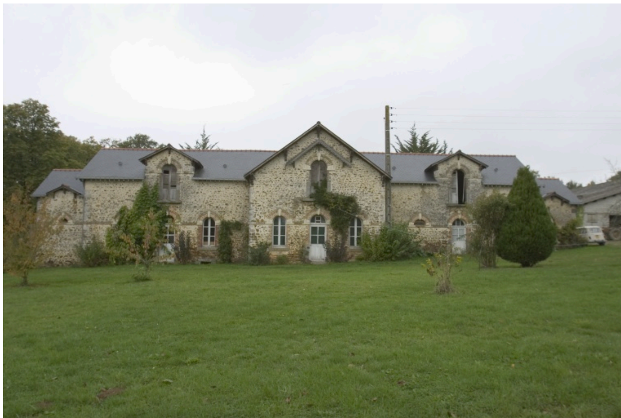
Le logis-écurie vu depuis l'est.
